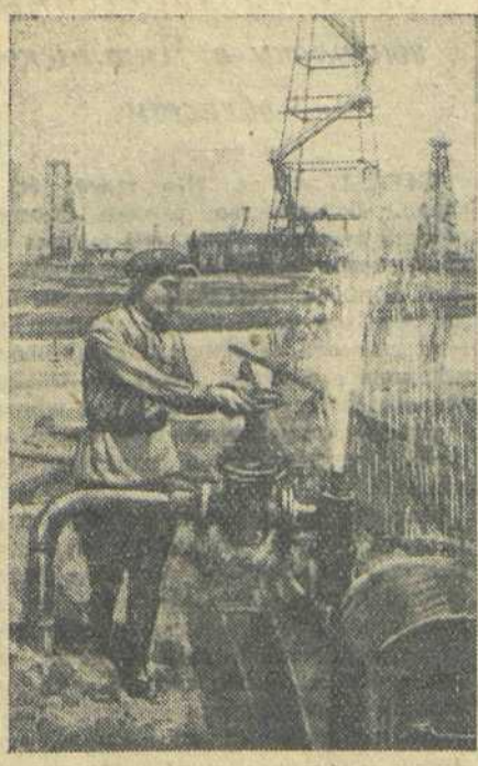
В Ишимбае (Башкирская АССР) работает новый завод Наркомхимпрома, добывающий паровую соль из буровых вод нефтяных скважин. Ввод в эксплуатацию программы. На снимке: насос, выкачивающий буровые воды. У насоса — механический вентиль тов. Калугин. Фото В. Чернышевой. (ТАСС).
